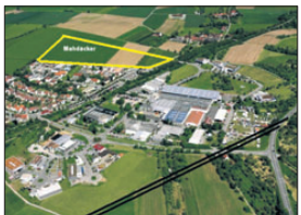
Gewerbegebiet Mahdacker in Leutenbach: „Eine absolute Premiulage“, sagt Bürgermeister Jürgen Kiesel über die Gewerbeflächen in Nellmersbach unweit der neuen B 14 und fünf Minuten zu Fuß vom S-Bahnhof entfernt. Von den fünf Hektar seien bereits zwei verkauft. Preis: 115 Euro je Quadratmeter.
